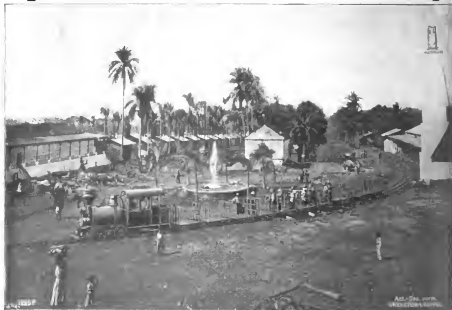
Ansicht einer von uns nach Guatemala gelieferten Plantagenbahn.
